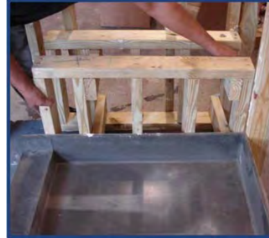
Photo d'installation No 2
