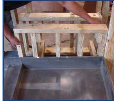
Photo d'installation No 2
