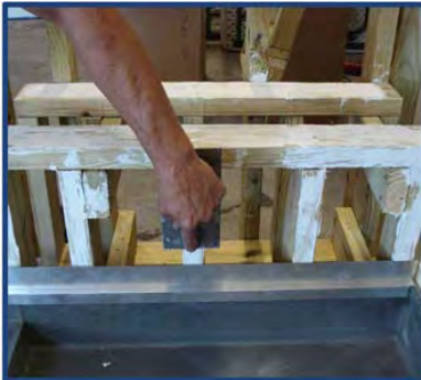
Photo d'installation No 5
