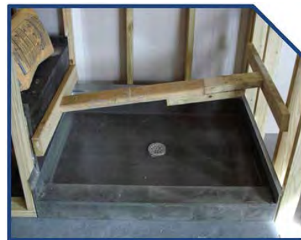
Photo d'installation No 8
