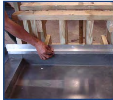
Photo d'installation No 4
