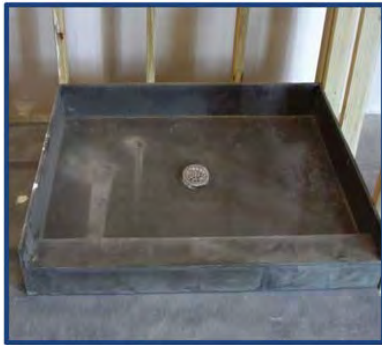
Photo d'installation No 3
