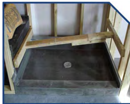
Photo d'installation No 8
