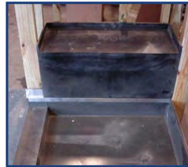
Photo d'installation No 6
