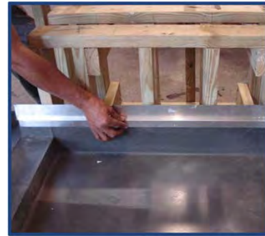
Photo d'installation No 4
