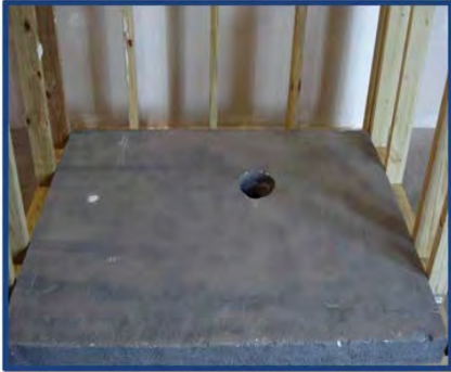
Photo d'installation No 1
