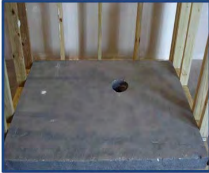
Photo d'installation No 1
