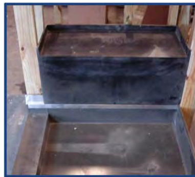
Photo d'installation No 6
