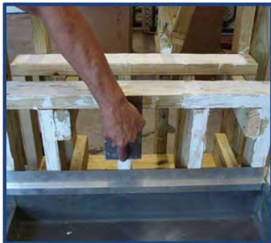
Photo d'installation No 5
