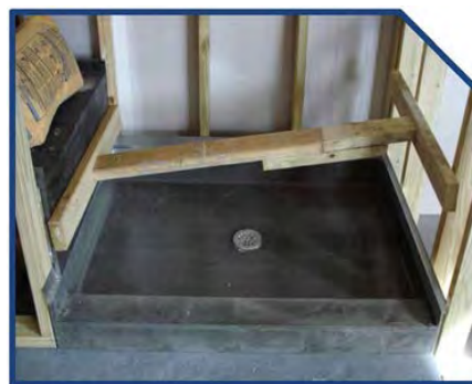
Photo d'installation No 8
