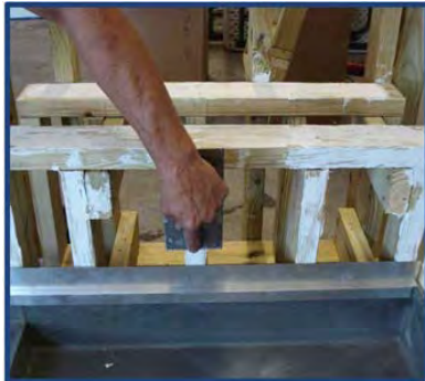
Photo d'installation No 5
