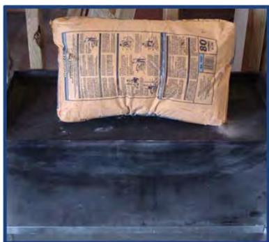
Photo d'installation No 7
