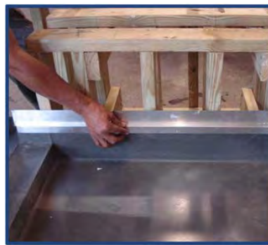
Photo d'installation No 4
