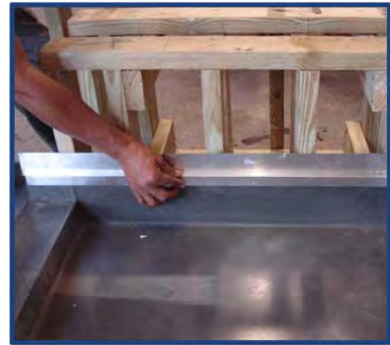
Photo d'installation No 4
