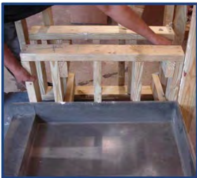
Photo d'installation No 3
