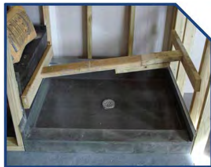
Photo d'installation No 8
