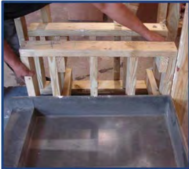
Photo d'installation No 3
