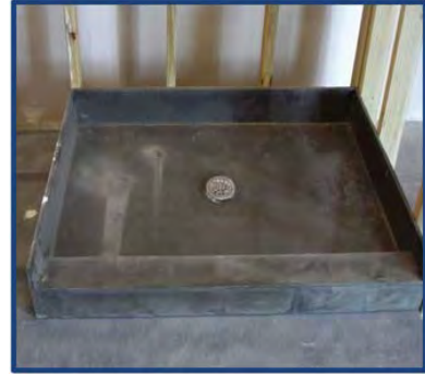
Photo d'installation No 2
