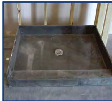
Photo d'installation No 2
