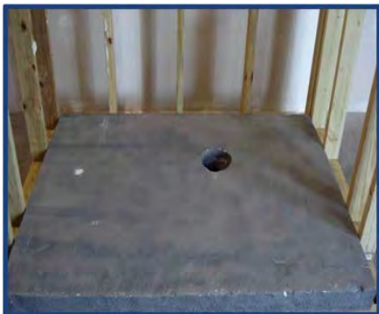
Photo d'installation No 1
