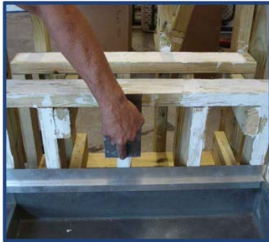
Fotografía de instalación 5
