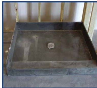
Photo d'installation No 2
