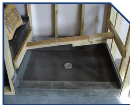
Photo d'installation No 8
