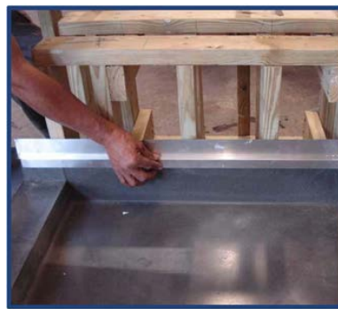
Photo d'installation No 4
