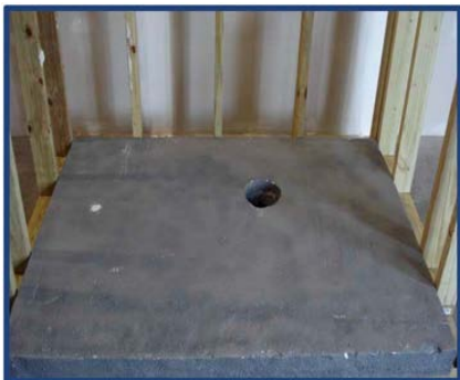
Photo d'installation No 1
