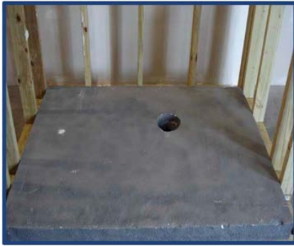
Fotografía de instalación 1
