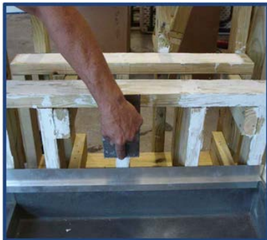
Photo d'installation No 5
