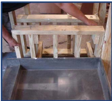
Photo d'installation No 3
