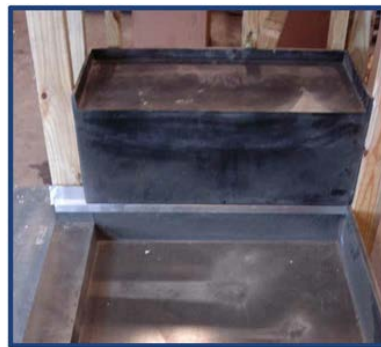
Photo d'installation No 6
