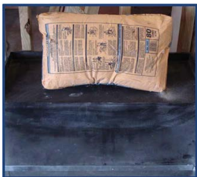
Photo d'installation No 7
